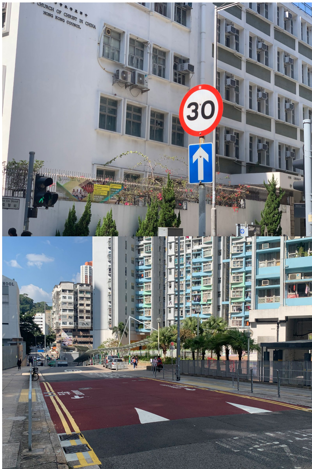
圖 31、32: 運輸署在深水埗偉志街試行的時速 30 公里低速區，附有限速標誌和減速平台
