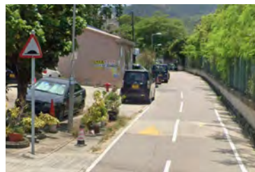
屯門藍地桃勵路減速平台
